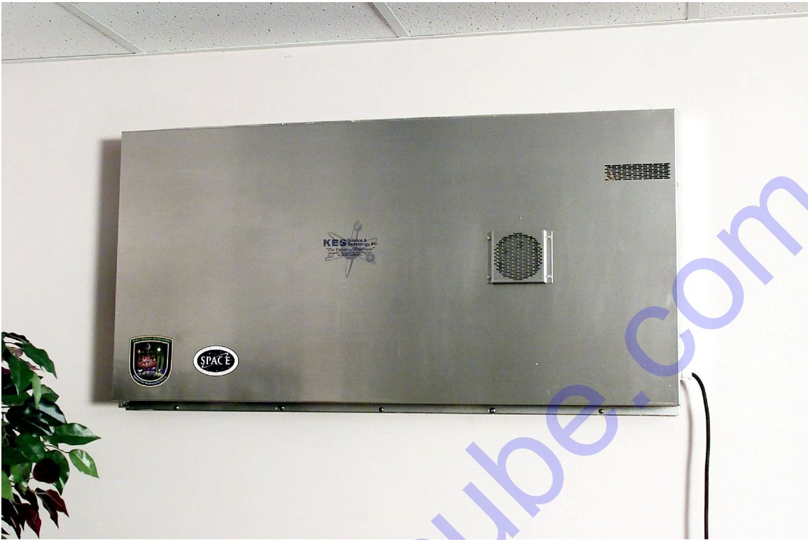
Figura 3. Filtro fotocatalitico per impieghi astronautici, installato come depuratore a ricircolo: un buon esempio di ricaduta negli impieghi civili degli investimenti destinati alla corsa nello Spazio.
